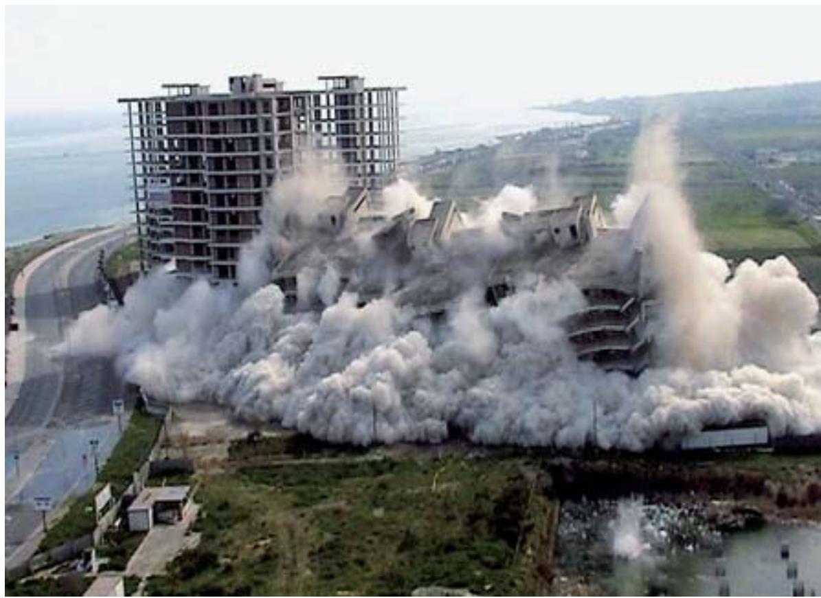
La demolizione | I palazzoni di Punta Perotti furono demoliti nell'aprile del 2006
