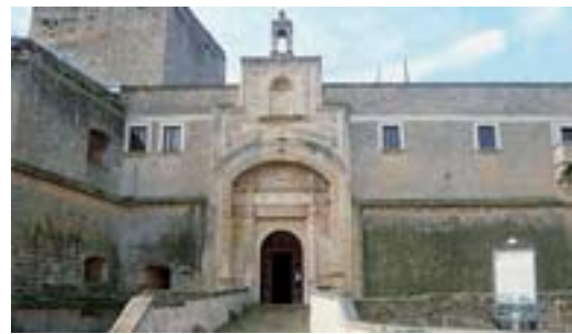
Copertino, Castello Angioino
